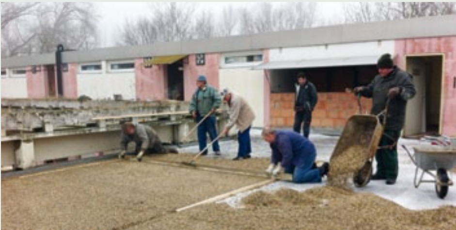
Die Arbeiten am Vereinsheim des FV Dürnkrot gehen voran
